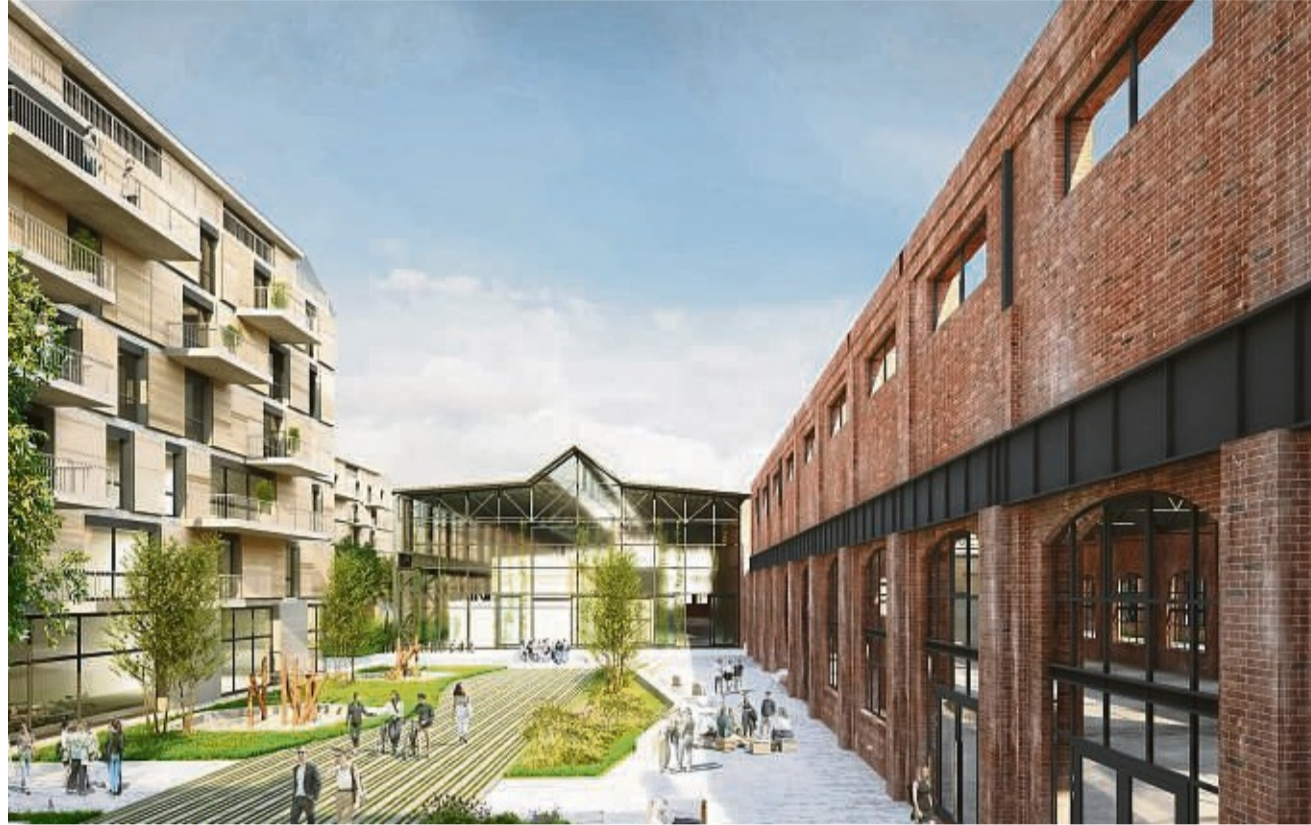
Neubauten sollen denkmalgeschützten Bestand ergänzen: Für den gläsernen Verbindungsbau in der Mitte ist ein Markthallenkonzept in Planung, das Nahversorger und einen Food-Markt vorsieht.
